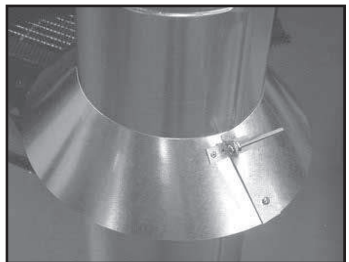
Figur 46. Sammensetting av stormkragen rundt røret
