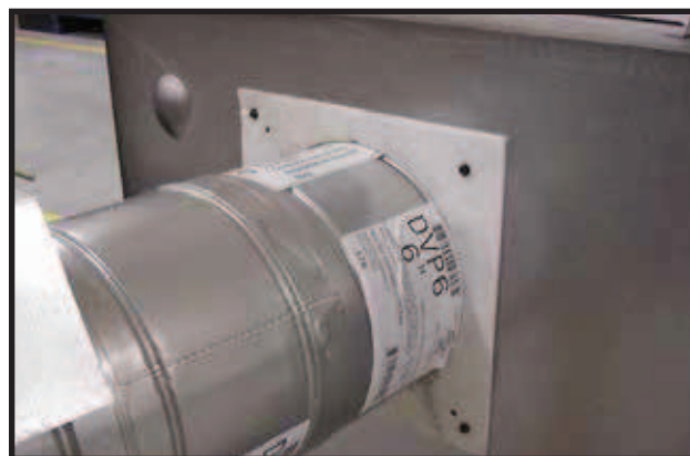
Figur 27. Fest den første delen av avtrekksrøret (den vil klikke på plass). Trekk isolasjonspakningen over avtrekksrøret, inntil kassen og over tappene. Bruk to mutterløse skruer til å feste pakningen til kassen.
