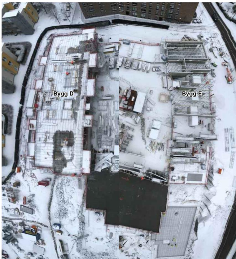
Oversiktsbilde av byggeplass fra kran, datert 13.03.2023
