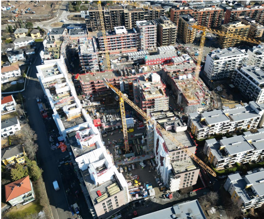
Oversiktsbilde med drone av byggeplass, datert 22.03.2024
